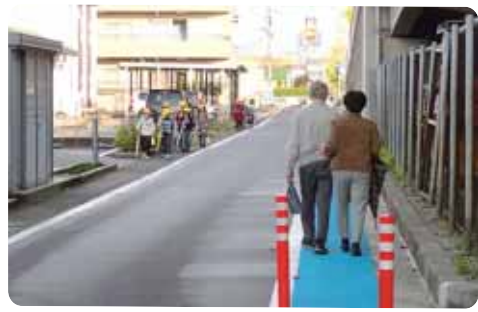
高齢者と子どもにやさしい街づくりに向け、カラー塗装された舗装道路
