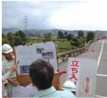
災害にあった高善寺橋を視察
