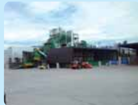
㈱グリーン発電会津にて間伐材を利用する木質バイオマス発電施設を視察
