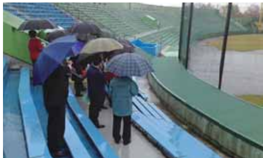
老朽化が進む県営野球場を視察(富山市五福)
