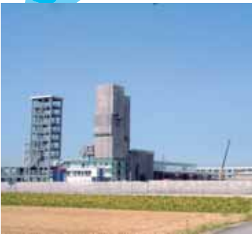
新保地内に建設中の消防学校
