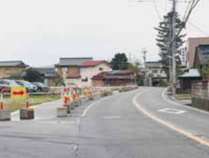
道路フレッシュアップ事業(婦中町広田地内の歩道新設)
